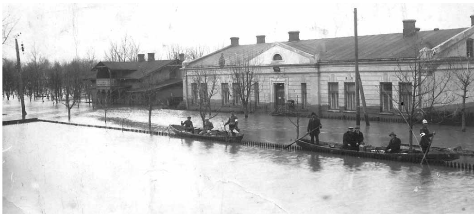
W moich zbiorach są zdjęcia wykonane w kwietniu 1924 r. Łódka płynie ulicą Kopernika, w tle widoczny jest obecny budynek MOPS-u. Ślady wody na ścianie wyraźnie wskazują, jakie rozmiary miała powódź.
