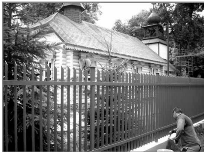
Odnawianie elewacji cerkwi oraz ogrodzenia
