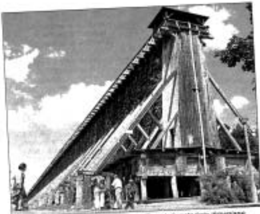
Tężnia – trzy unikalne i największe w Europie konstrukcje drewniane wzniesione w latach 1828 – 1852 według projektu prof. Jakuba Galla. Podstawę ichni stanowiły cztery słupy, na których umieszczono dwukrotnie-sosnową konstrukcję wypełnioną tężniem. To właśnie po niej spływa solanka. Wysokość jejni wynosi 15,8 m.
